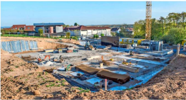
Der Verbindungstunnel zum Hauptgebäude (rechts im Hintergrund) ist bereits hergestellt, die Bodenplatte gegossen. Bis zum Herbst 2018 soll das Gebäude funktionstüchtig sein. Fotos: Rolf Willy
