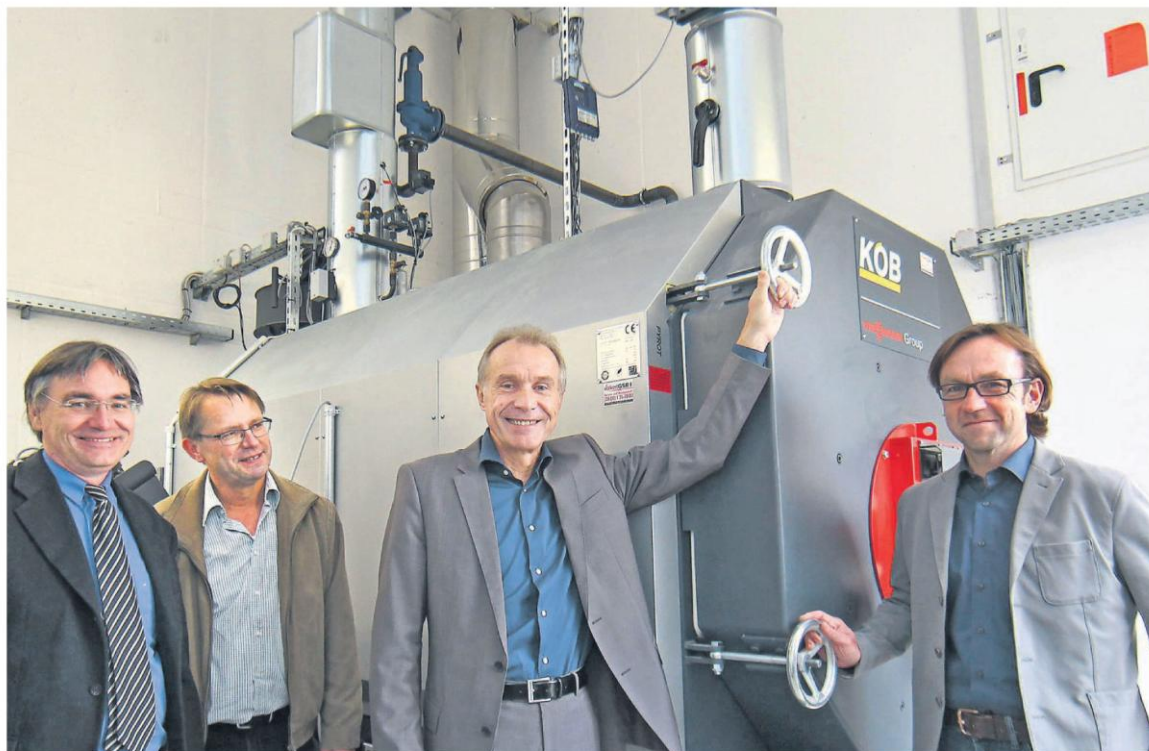
Vor dem neuen Heizkessel: (von links) Professor Martin Kreeb, Fachingenieur Norbert Betz, Bürgermeister Rolf Kieser, Architekt Wolfgang Reinhardt. Foto: Andreas Veigel
