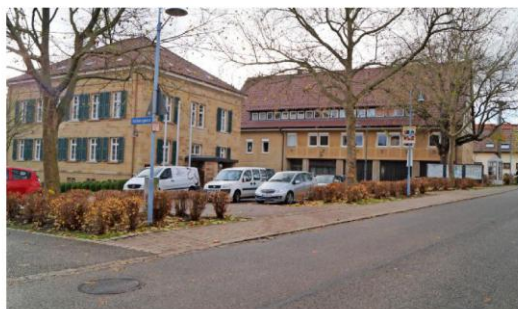
Im denkmalgeschützten Rathaus (l.) ist der Platz knapp. Wird das dazugehörige Gebäude (r.) abgebrochen, kann dort ein Neubau realisiert werden. Foto: Khattab
