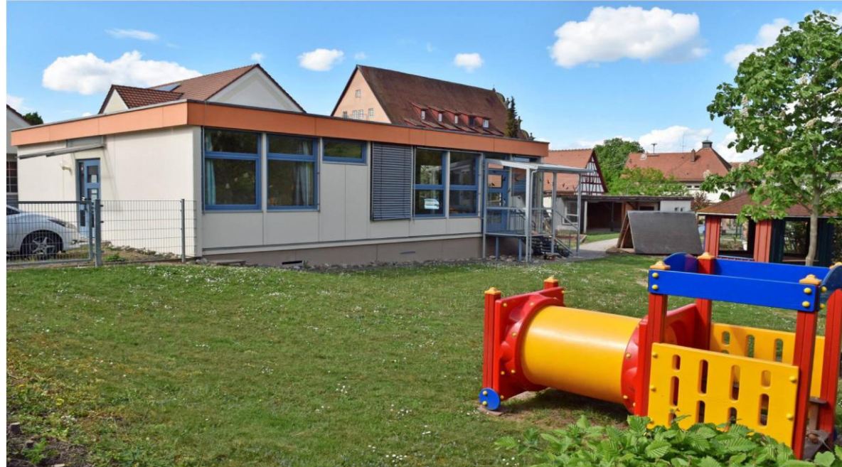
Der mehr als 25 Jahre alte Pavillon wird abgerissen. An seiner Stelle wird ein neuer Kindergarten gebaut.
