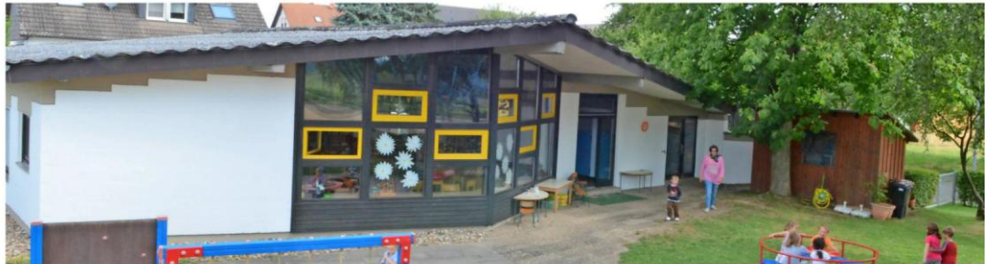
Der Kindergarten in Ochsenburg ist in die Jahre gekommen. Die Gemeinde hat einen Gutachter für die Sanierung geholt.
